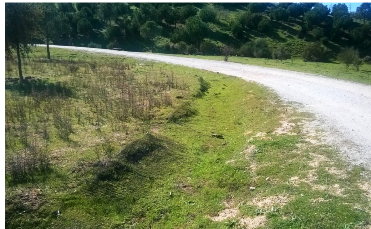
Cunetas verdes en el Parque Forestal de Valdebebas
