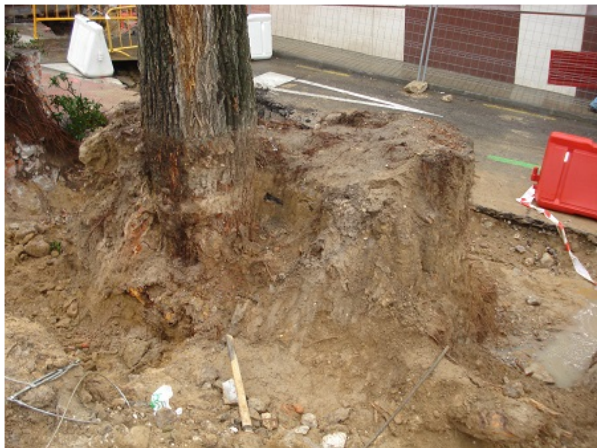
Afecciones a la base de un árbol por obras en la ciudad
